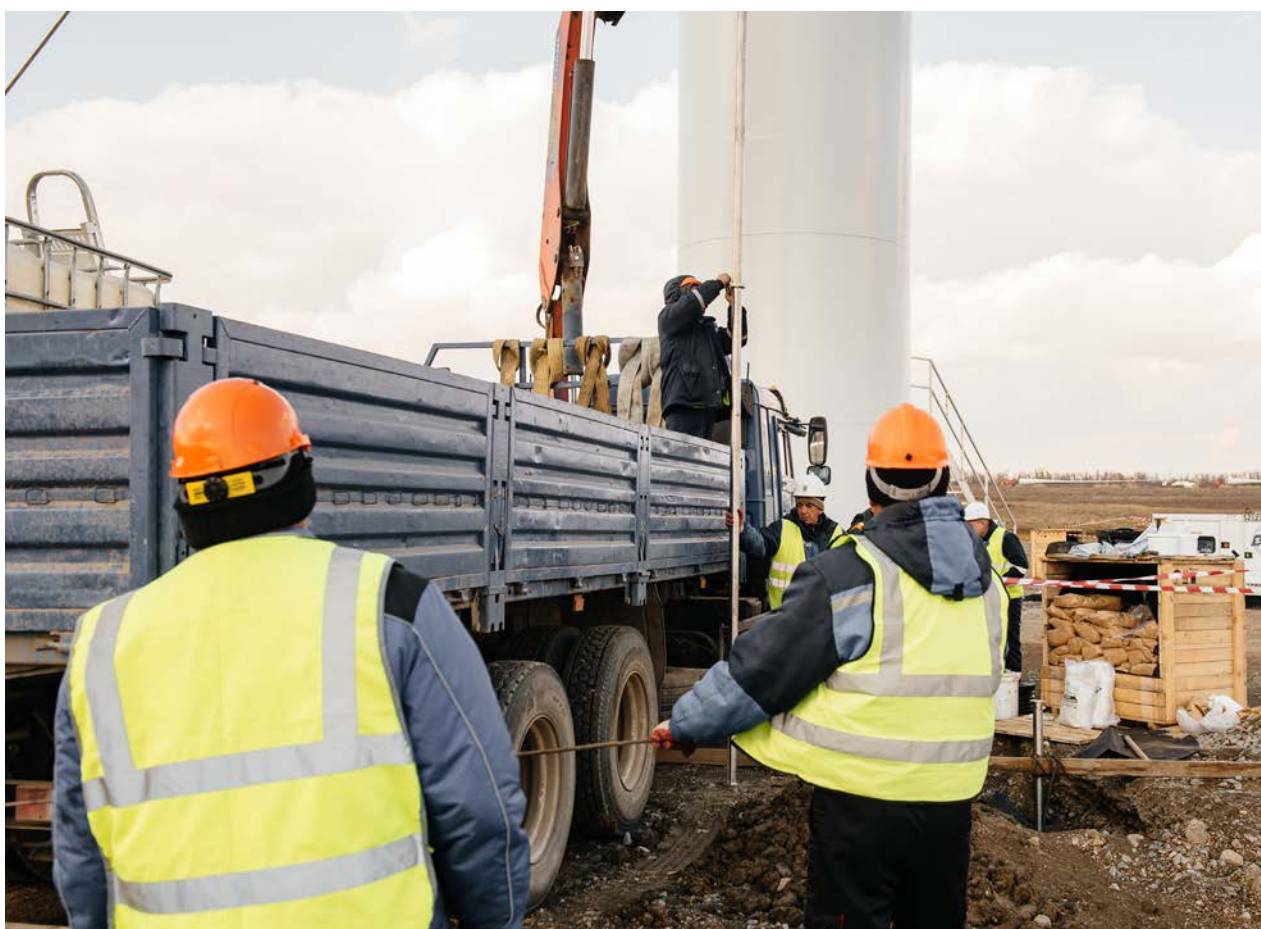
Фото 1-4. Шефмонтажные работы на объектах
