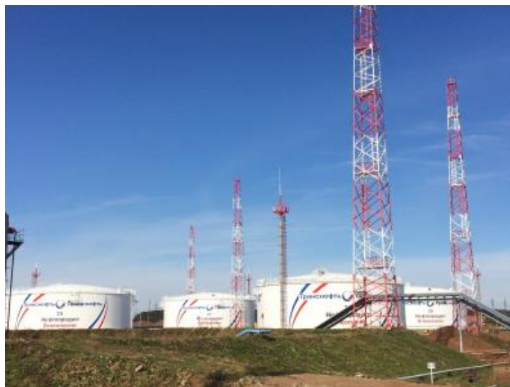
Резервуарный парк ЛКДС Черкассы Транснефти
