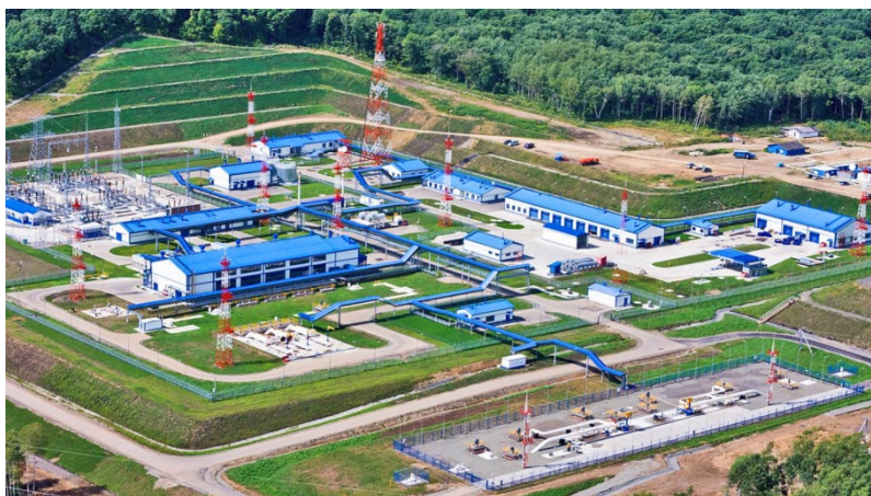
НПС №2, 3, 5, 6, 7, 9 трубопроводная система «Восточная Сибирь – Тихий Океан»
