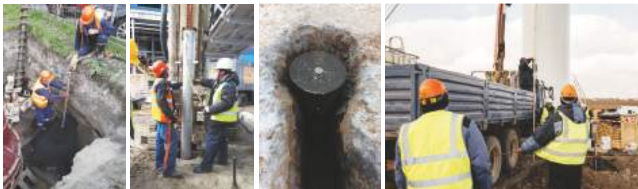
Фото 1-4. Шефмонтажные работы на объектах
