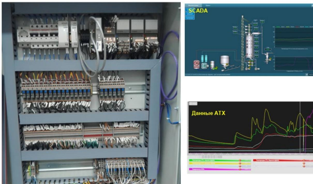
Рис. 1 Шкаф контроллера. Визуализация на APM
