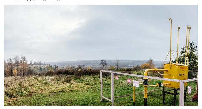
В декабре 2020 года в Костромской области введена в эксплуатацию газораспределительная станция (ГРС) в с. Парфеньево, входящая в состав магистрального газопровода «Галич-Мантурово-Шарья». Компания «ССТэнергомонтаж» приняла непосредственное участие в строительстве ГРС «Парфеньево», поставив на объект систему электроогрева на основе саморегулирующегося нагревательного кабеля.
