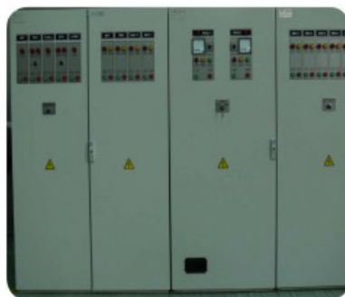
Комплектная трансформаторная подстанция (на базе шкафов ШНН по ТУ 3433-092-12261711-2010)
