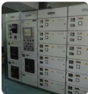
Агрегатный щит силового управления (на базе шкафов ШНВ по ТУ 3433-052-12261711-2010)
