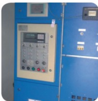
Система автоматического управления СКУ «R-5000» по ТУ 3435-087-12261711-2009
