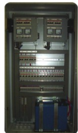
Комплектная трансформаторная подстанция (на базе шкафов ШНН по ТУ 3433-092-12261711-2010)
