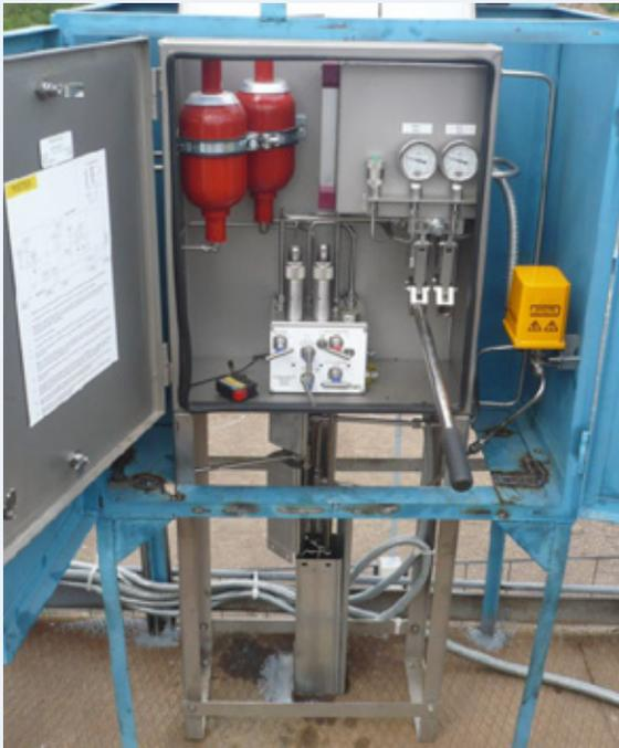
Для возможностей автоматического и дистанционного управления отсечением газовой скважины, установлен клапан ESD<sub>1</sub> (фирмы "Swagelok") с электроприводом. Клапан подключен в гидравлическую линию станции "SCCS", согласно рекомендациям Petro Controls Systems, параллельно существующему ручному клапану ESD. Питание и управление клапаном с электроприводом обеспечивается ШТ.А.
